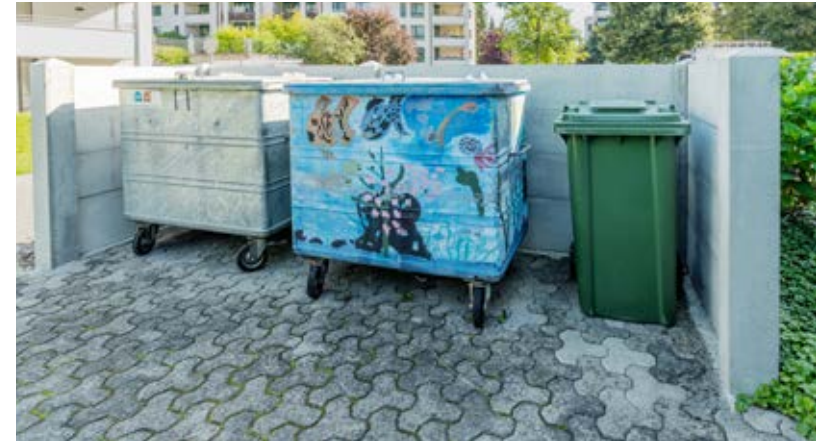
Les poteaux pour planches en béton servent, avec les planches en béton à arêtes vives, de cache-containers
