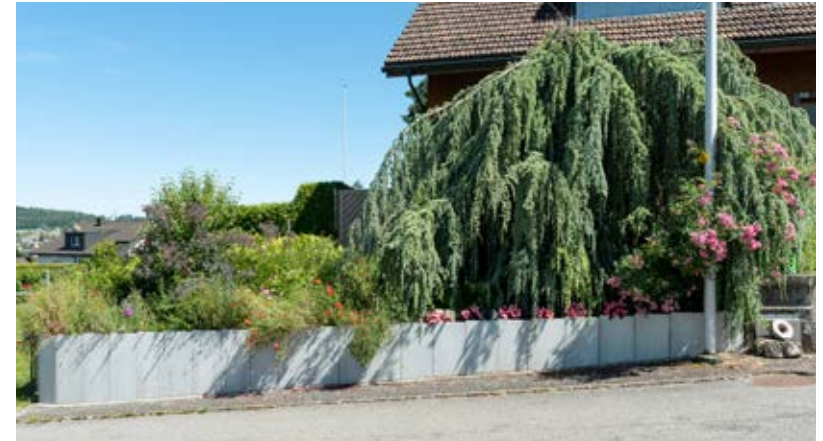
Planches en béton, arêtes vives en tant qu'encadrement
