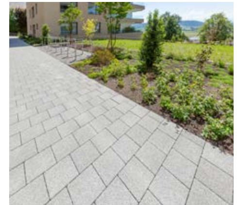
Pavés filtrants CARENA® pose à l'anglaise
