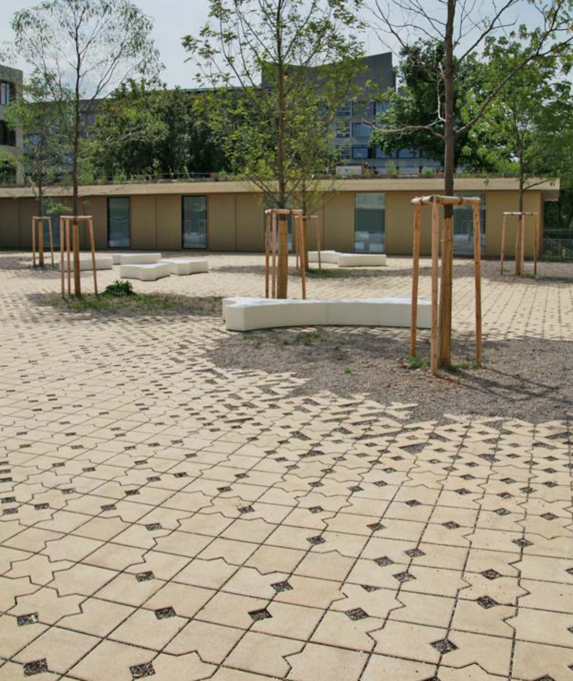
Pavés en béton EIGEN-KREATION, école Sandgruben de Bâle
