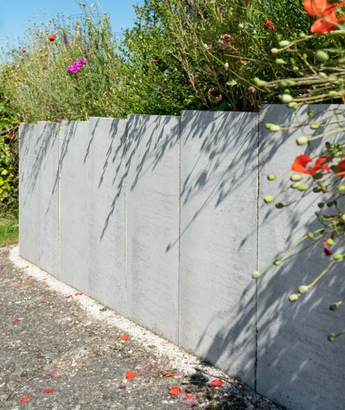
Planches en béton, arêtes vives
