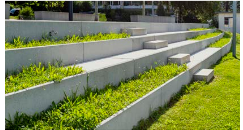
Éléments en équerre ROZTEC® MINI sablés en tant que tribune d'un terrain de sport
