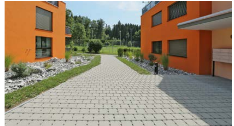
Pavé résistant au poids lourds VS 5 ® avec 5 fois plus de résistance au déplacement, gris, pose à l'anglaise
